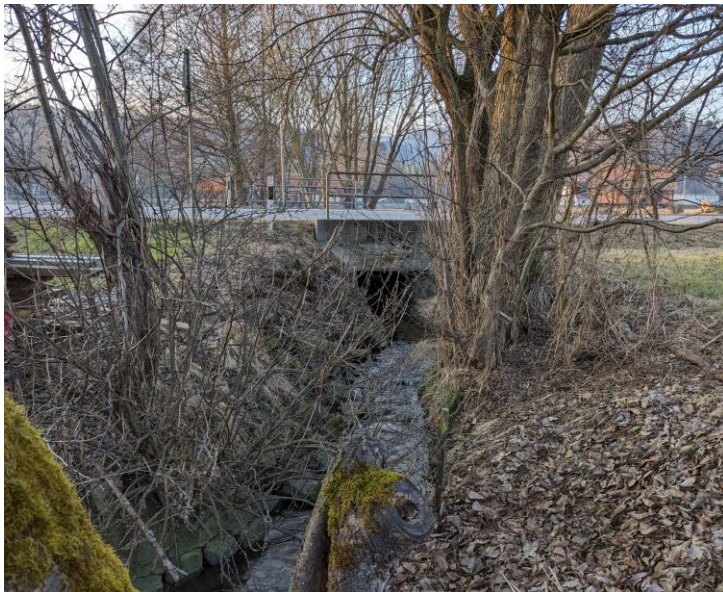
Bild: Durchlass bei St 2140
