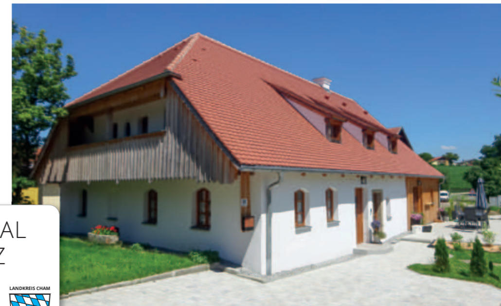
Die denkmalgeschützte ehem. Schmiede in Biberbach, Gemeinde Treffelstein, ein eingeschossiges und traufständiges Wohnstallhaus mit Halbwalmdach und Giebelschrot aus der 1. Hälfte des 19. Jahrhunderts wurde mit enormer Eigenleistung vorbildlich saniert.
