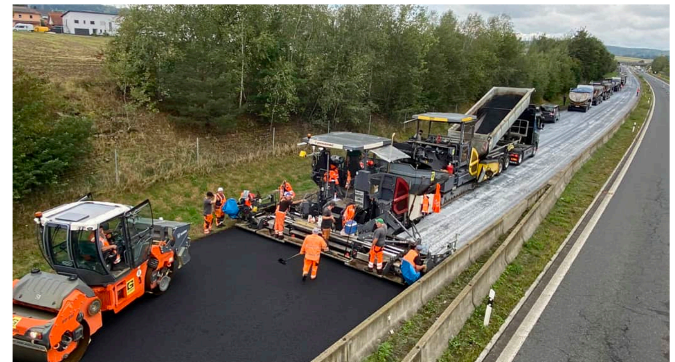
B 85 Fahrbahnsanierung Untertraubenbach – Cham (Süd-Fahrbahn): Einbau temperaturabgesenkter Asphalt
