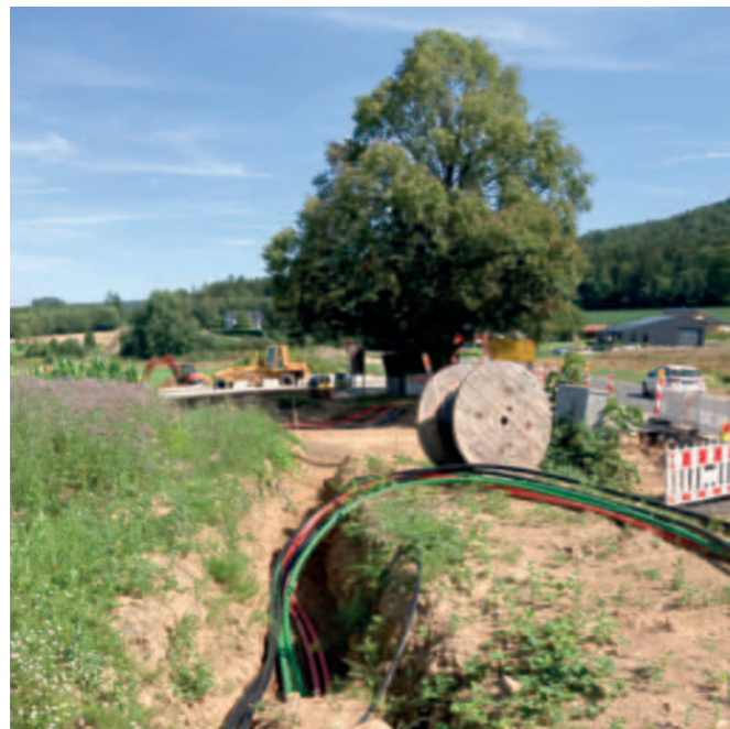
St 2146 Geigant – Zillendorf: Straßen- und Leitungsbau im Einklang mit dem Naturschutz
