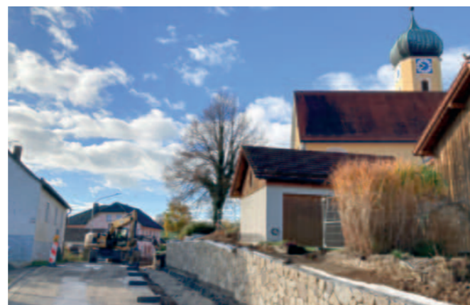
St 2151 OD Bernried: Erneuerung der Fahrbahn und der Seitenbereiche
