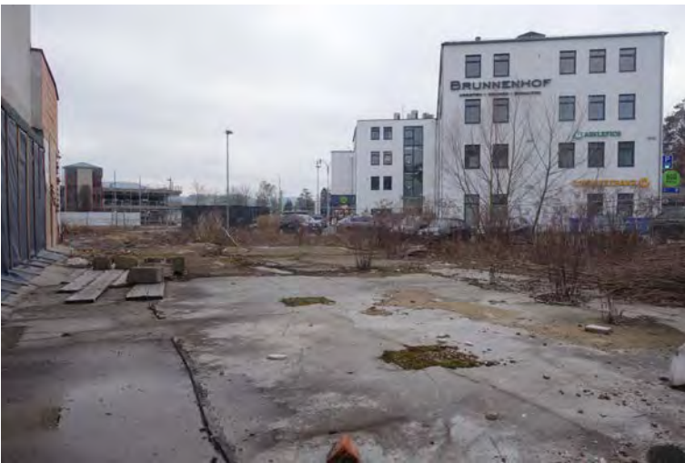
Auch im Bereich Brunnendorf finden sich Brachen auf den Flächen abgerissener historischer Gebäude
