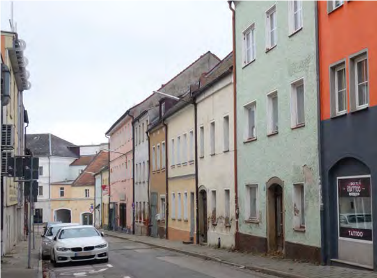
In der Judenstraße findet sich eine Konzentration von städtebaulichen Missständen: Sanierungsbedarf; Leerstand; dunkle, enge Grundstücke; unattraktiver Straßenraum
