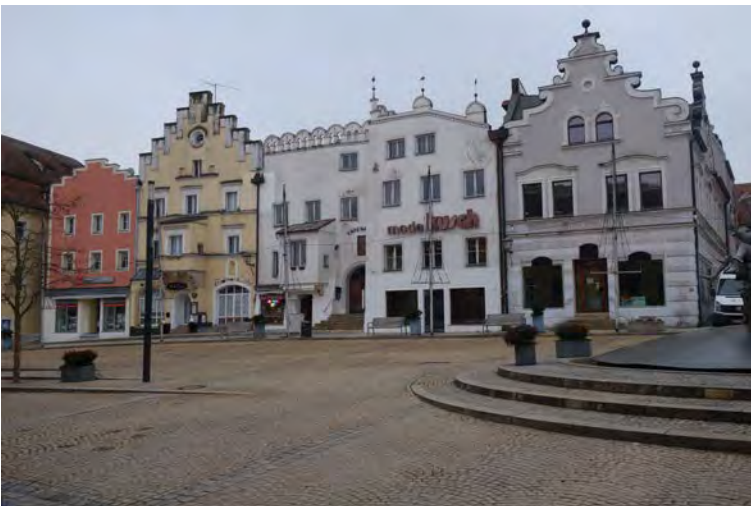
Die Zeile am Marktplatz umfasst mehrere Baudenkmale und ein Denkmalensemble. Hier gibt es Leerstände von Einzelhandel und Gastronomie in bester Lage
