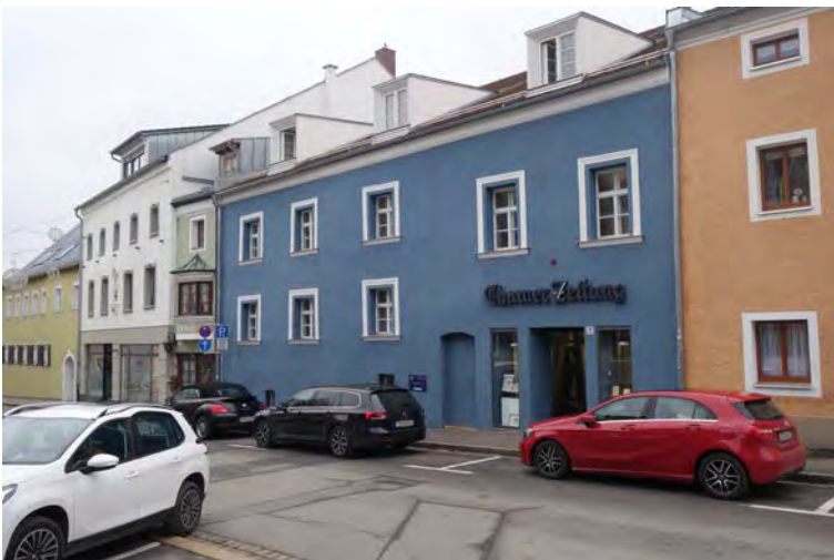
Das denkmalgeschützte „Blaue Haus“ wurde umfassend saniert
