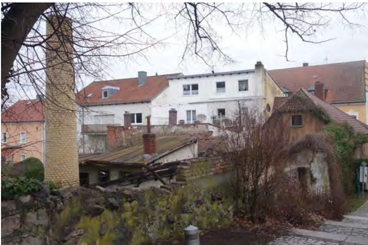
Städtebauliche Missstände im ehemaligen Stadtgraben am Spitalplatz
