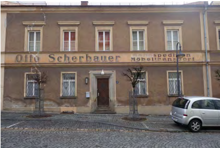
Stadtbildprägendes Gebäude in der Schulstraße
