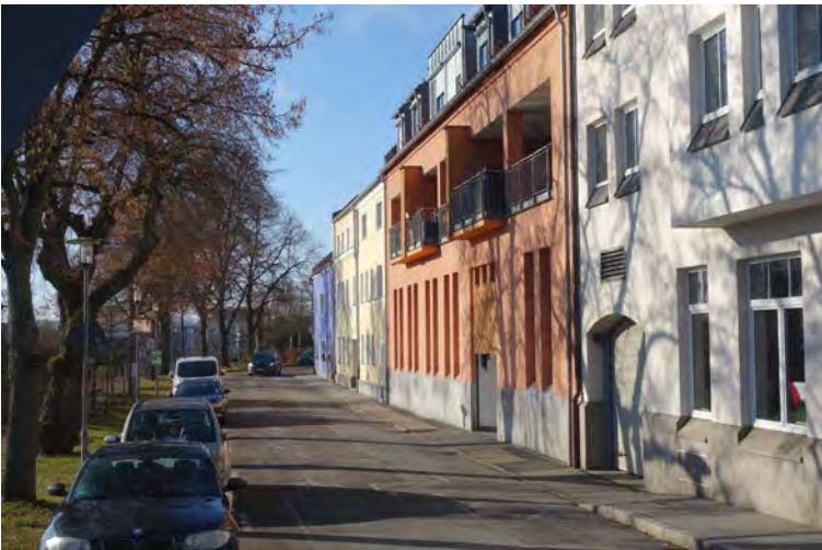
In der Unteren Regenstraße wurde eine Quartiersgarage im Untergeschoss eines Wohnhauses neu errichtet
