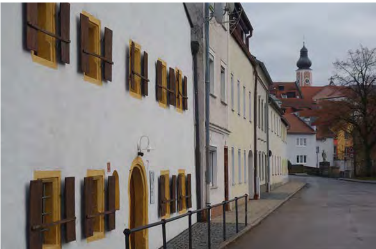
Die Zeile an der Schützenstraße mit sanierungsbedürftigen, ortsbildprägenden Gebäuden wird zur Einbeziehung in das Sanierungsgebiet vorgeschlagen
