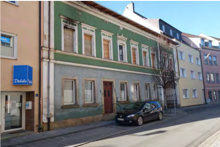
Ortsbildprägendes Wohnhaus in der Propsteistraße mit Leerstand und hohem Sanierungsbedarf
