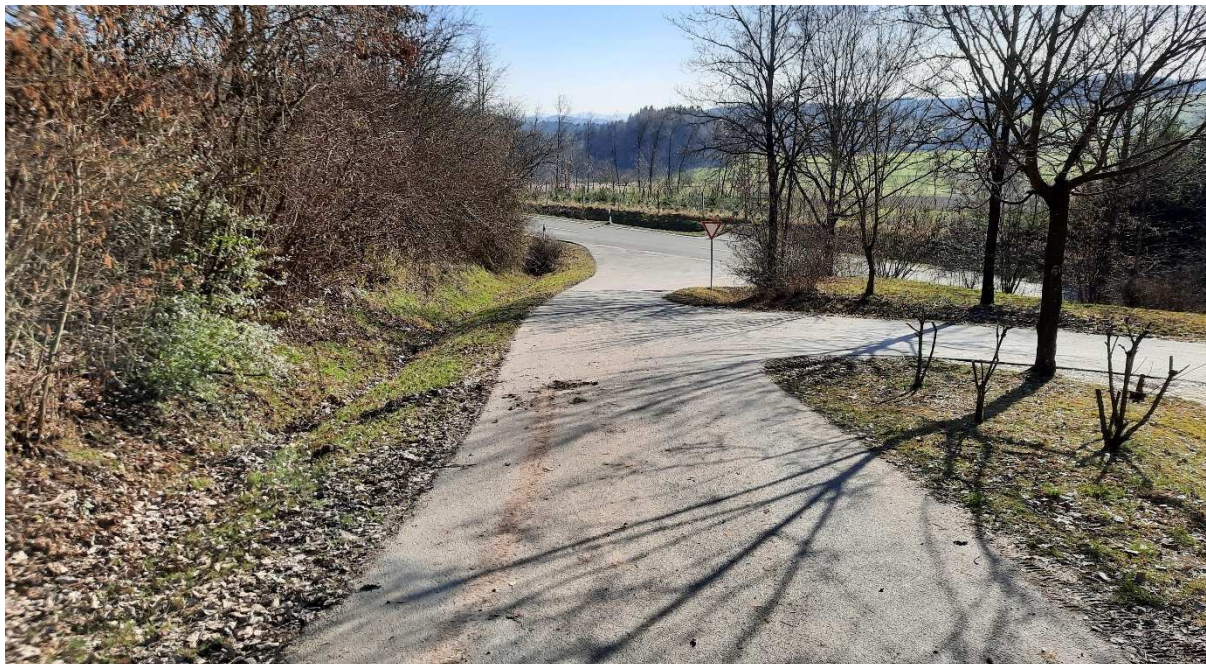
Blick von Norden auf die bestehende Zufahrt zum Friedhof (nach rechts) und auf die Kreisstraße CHA10
